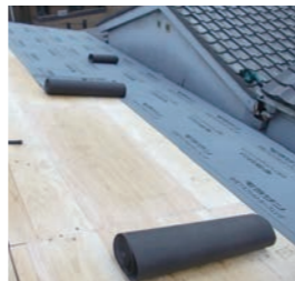
防水シートの設置
